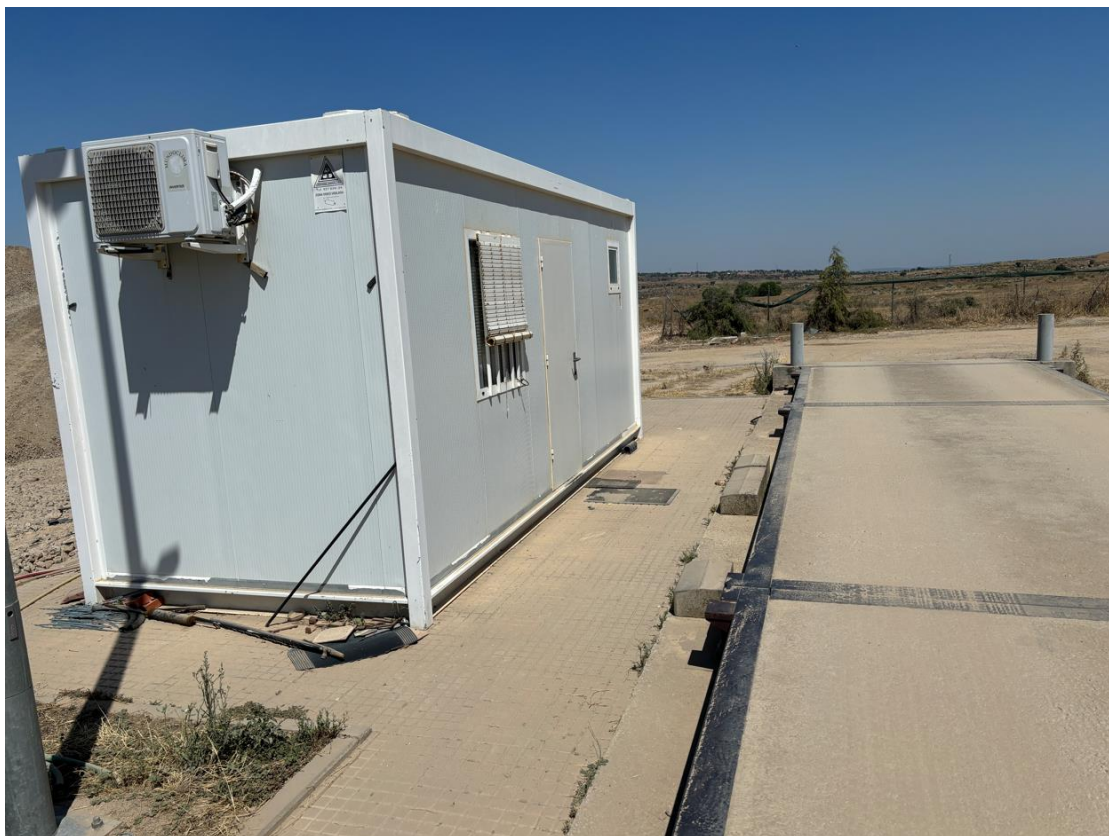
Fig. nº 12. Caseta control y báscula
