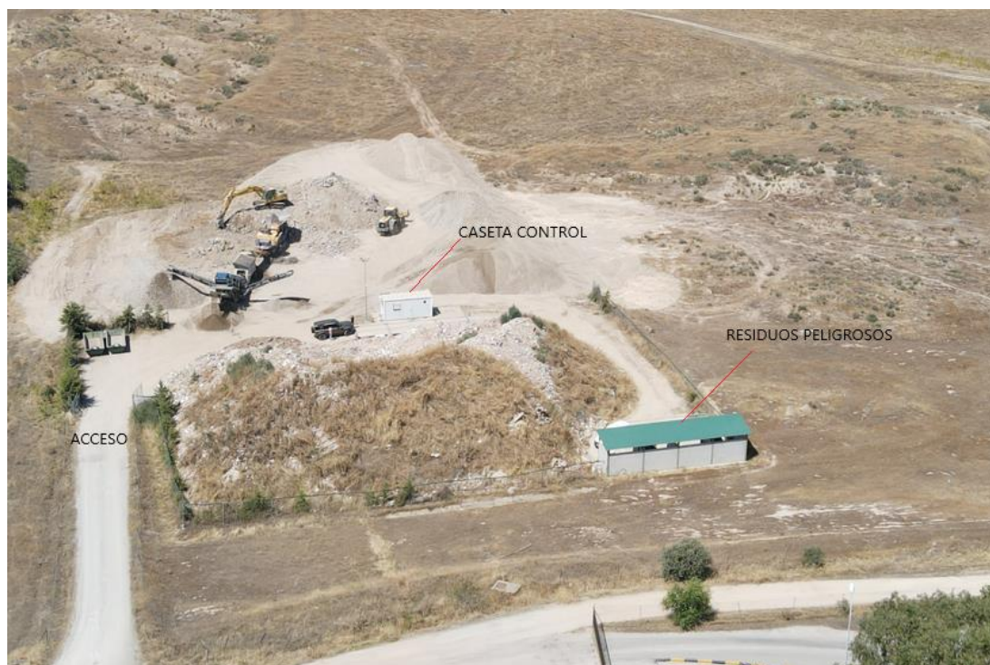
Fig. n° 13. Detalle de las casetas existentes. Control y residuos peligrosos
